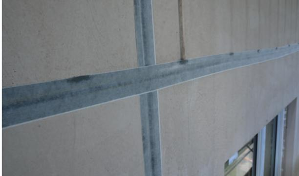
Dampfdichtes Abkleben der bestehenden Fugen
